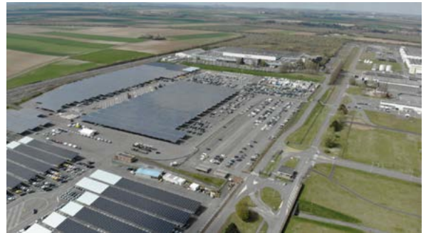
La zone d'implantation de l'usine Envision (parties Sud et Ouest de l'usine de Renault de Douai)
